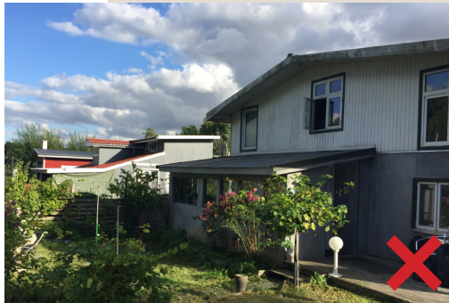
Byggeri i to etager tillades ikke.
