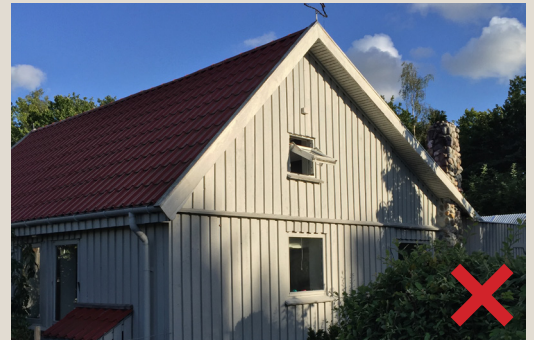
Byggeri i to etager tillades ikke.
