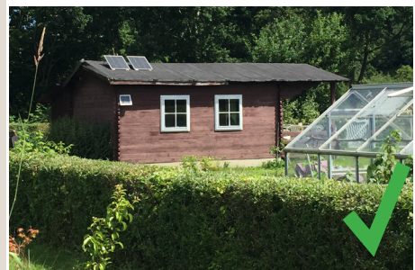
Eksempel på et havehus hvor solcellerne er tilpasset havehuset i omfang og udformning og derved ikke virker dominerende.
