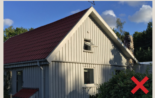
Byggeri i to etager tillades ikke.
