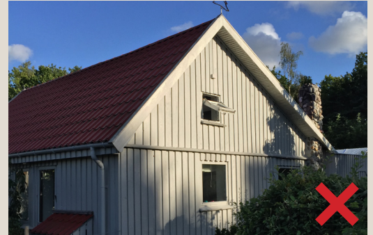
Byggeri i to etager tillades ikke.
