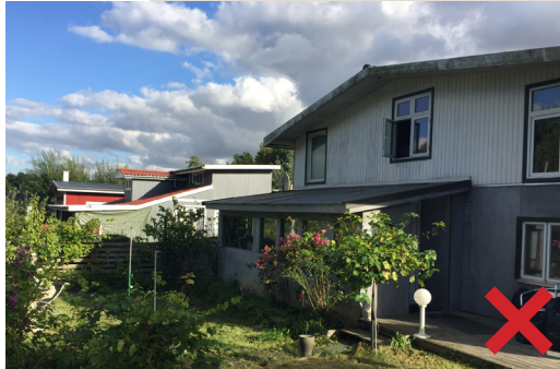
Byggeri i to etager tillades ikke.
