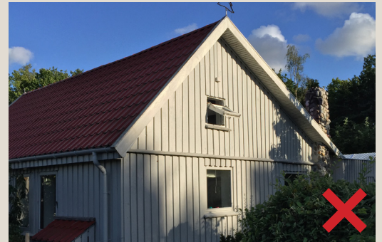
Byggeri i to etager tillades ikke.
