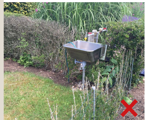
Eksempel på vask med ulovlig håndtering af spildevand, hvor spildevand siver direkte ned i jorden. Spildevand fra vasken skal opsamles i beholder, der tømmes i fælles tømmefaciliteter.
